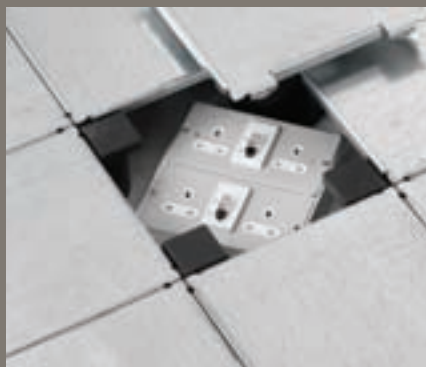
Slab box : RCD protection
